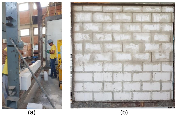
Figura A.1 - Detalhes da execução da amostra: (a) levantamento primeira fiada e (b) amostra finalizada
